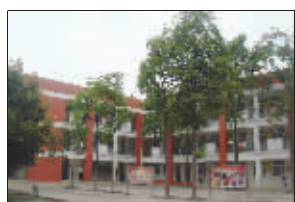
由江苏人民援助重建的新校园
