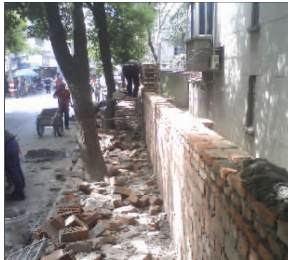
因为资金不足,原本该装铁栅栏的地方砌起了一堵墙
