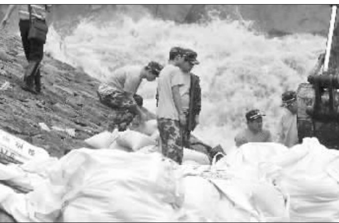
5月5日,武警、消防、民兵预备役等抢险人员正紧张地运送沙包加固大坝
