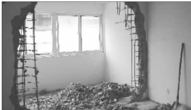
装修拆墙体,可能带来安全隐患
