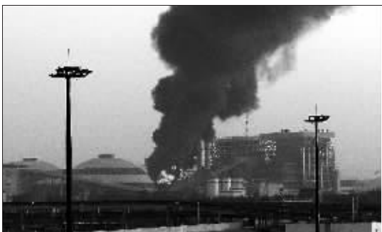
昨晚,华能金陵热电厂脱硫塔燃起大火 快报记者 顾炜 摄
