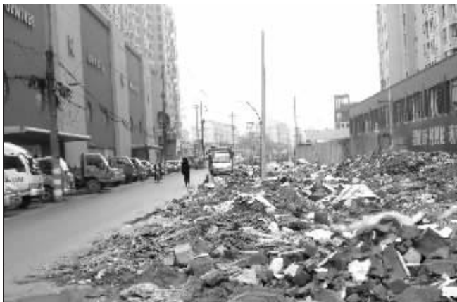
建筑垃圾霸占了半幅路面
