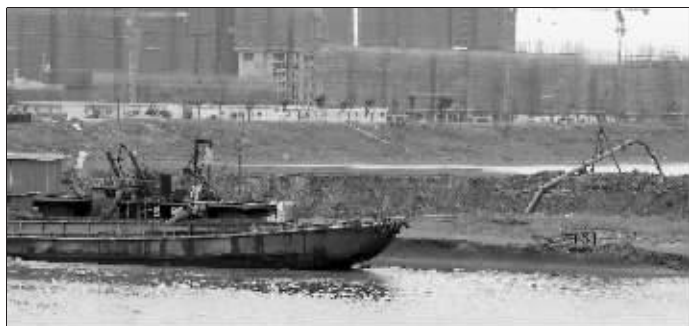
一艘清淤船正在向围堰中清排淤泥 快报记者 顾炜 摄
