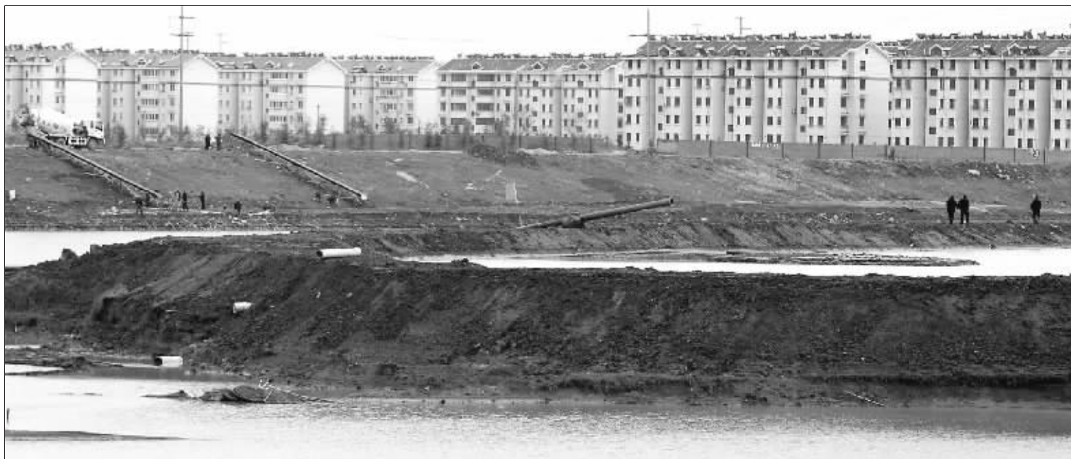
施工方在河道中建围堰以存放淤泥 快报记者 顾炜 摄
