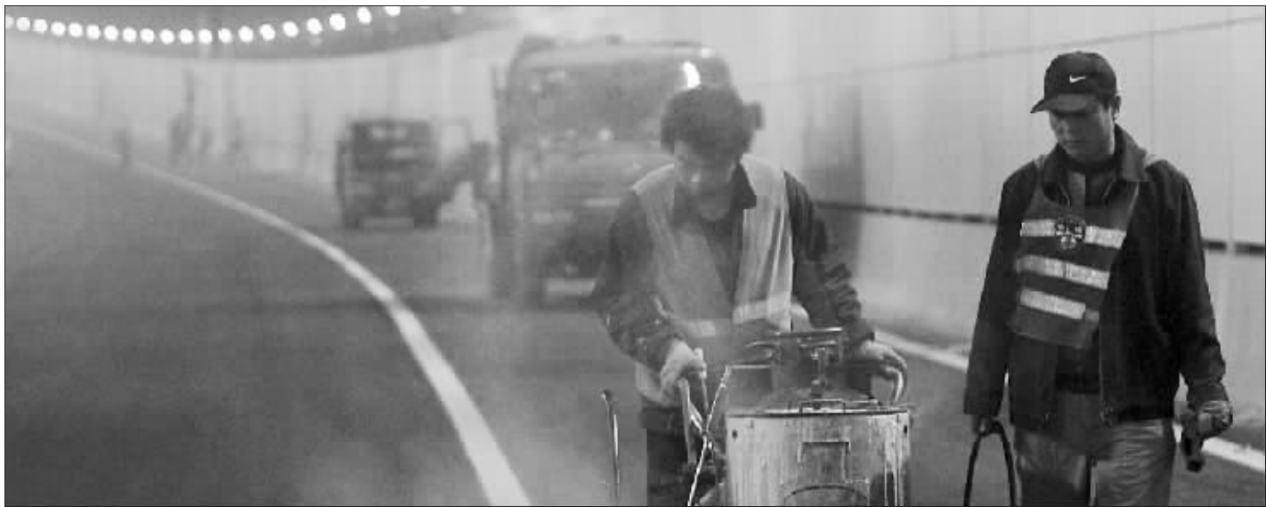
纬七路过江隧道内路面沥青已经摊铺好,开始画线 快报记者 顾炜 摄
