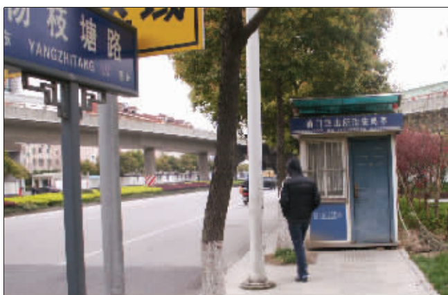
杨枝塘路北侧人行道被治安岗亭拦腰截断
