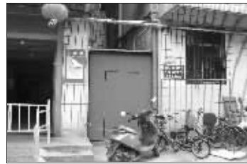
新建的铁皮房正好堵住了消防通道 快报记者 赵丹丹 摄
