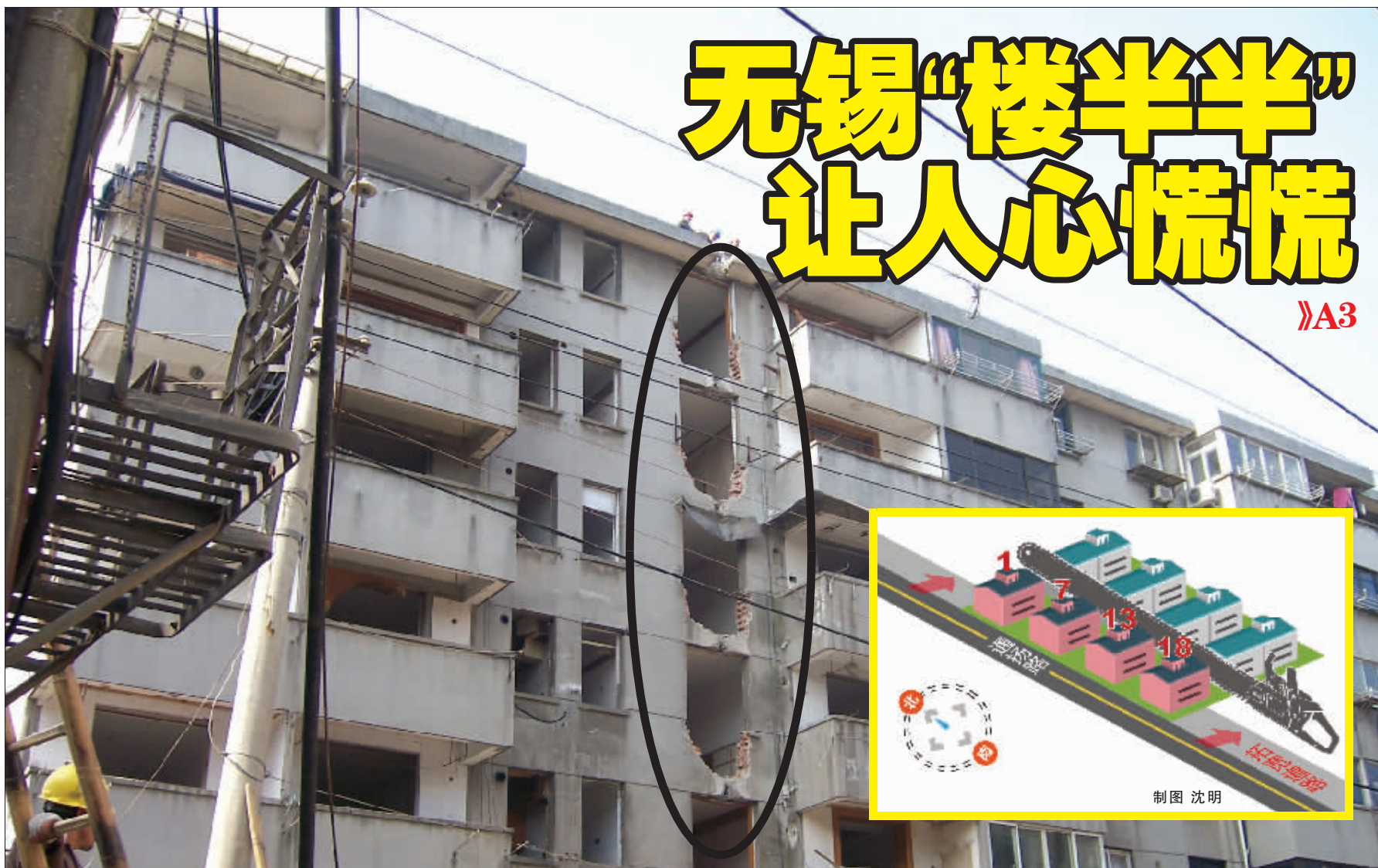
因为道路扩建,无锡市南长区水仙里小区的4排楼房要被“切割”掉三分之一。 快报记者 薛晟 摄 (注:图中画圈处为切割部位,小图为现场模拟图。)
