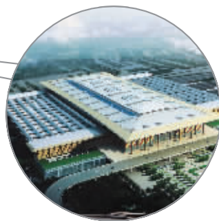
高铁南京南站
