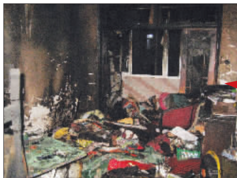
起火的房间,被烧得一塌糊涂
