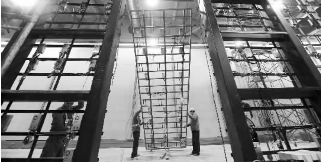
3月底,江苏馆的建设将全部完工
