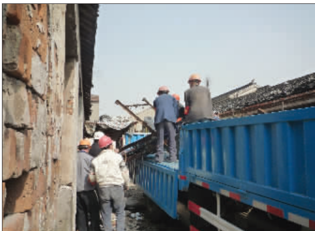
执法人员正在拆除废塑料品加工机器
