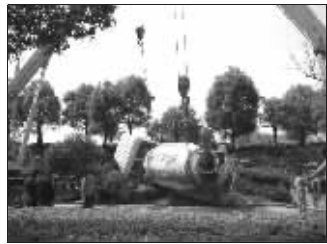
起吊搅拌车 快报记者顾元森 摄
