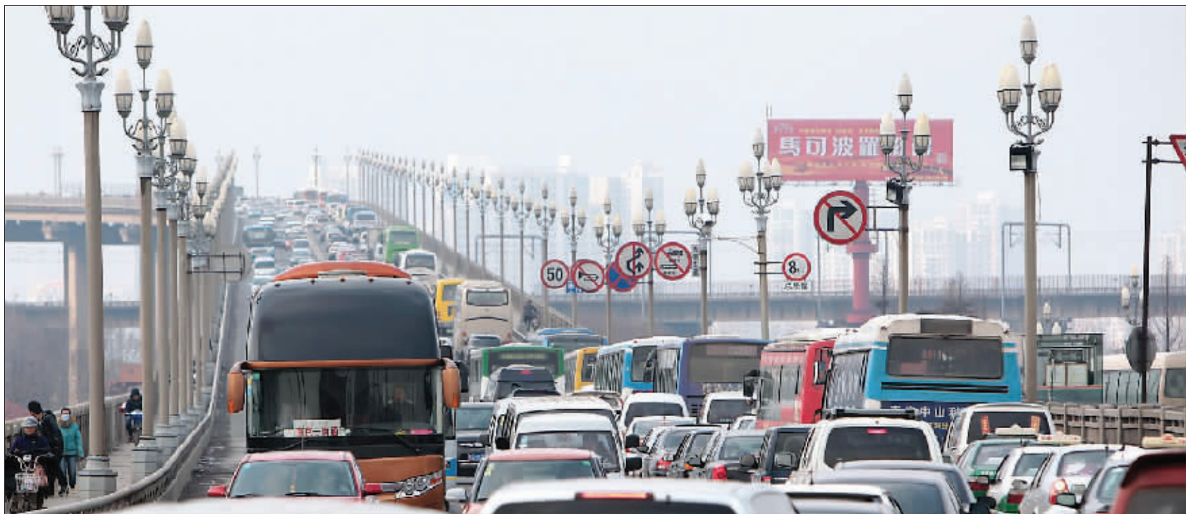
南京长江大桥每天都在超负荷承载车流。久拖病体的大桥是该大修了,可要大修,面临方方面面的问题却是如此棘手。 快报记者 顾炜 摄
