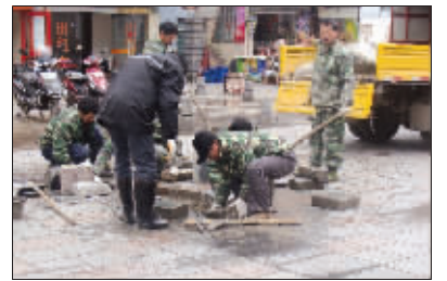
工人们维修受损路面
