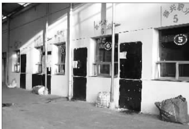
安德门民工临时宿舍被拆除,这里人去楼空 快报记者 项风华 摄
