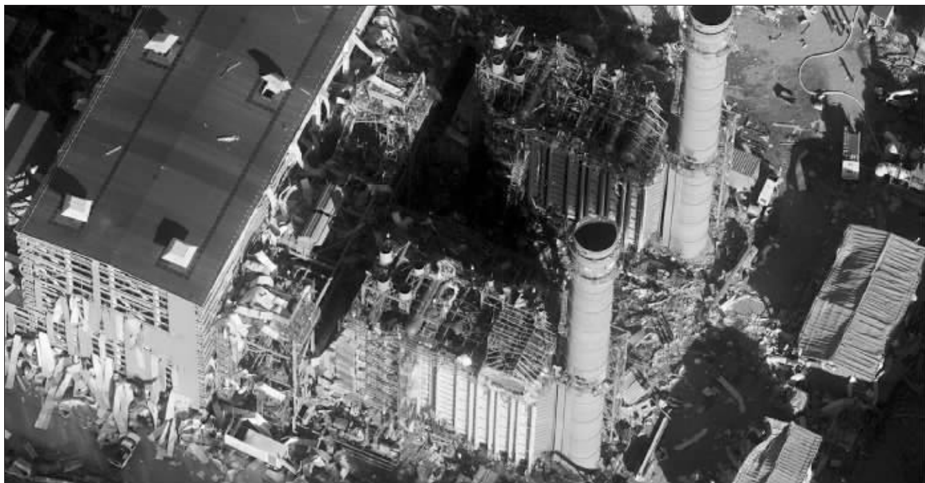
航拍爆炸现场
