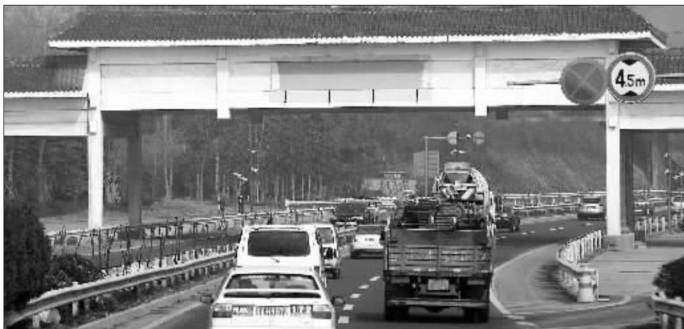
牌楼中间用水泥糊了一块,十分难看 快报记者 顾炜 摄
