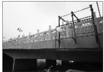
1月26日,汉中门“桥糊糊”的更换栏杆工作还在进行中。
