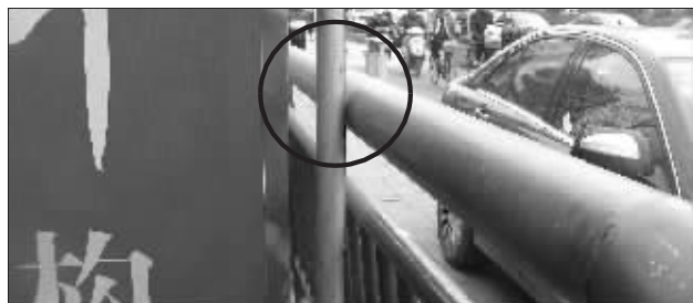
没有圈中这个支点,栏杆多半会倒向明御河 快报记者 孙玉春 摄
