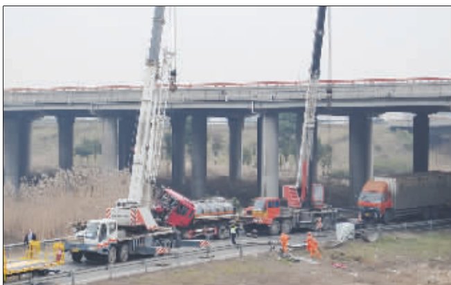
两辆吊车正在起吊槽罐车
