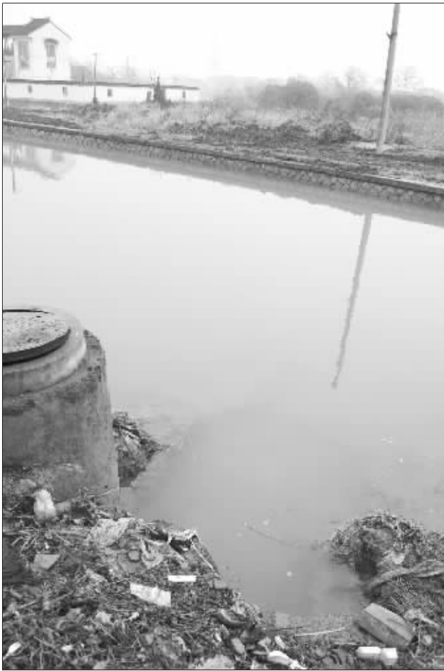
水管阀门旁的小河中混着漏出的自来水
