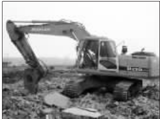
挖掘机正在毒土地上作业
