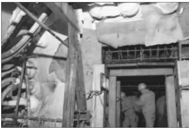
冷冻管周围已经形成了直径在 40 厘米左右的大“冰球”
