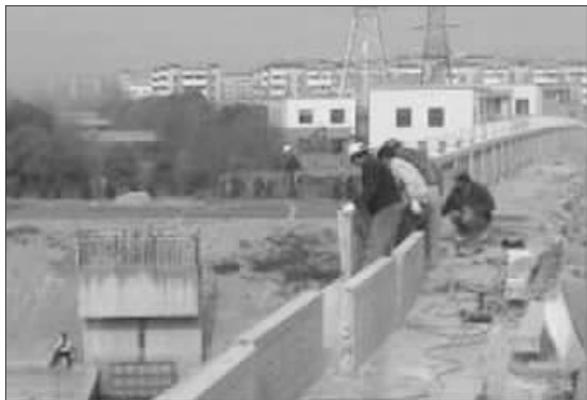
工人们正在维修银龙桥护栏
