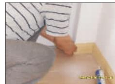
美庭的工人在安装实木地板时,十分认真仔细。此为工人经过墙壁墙角安装踢脚线。
