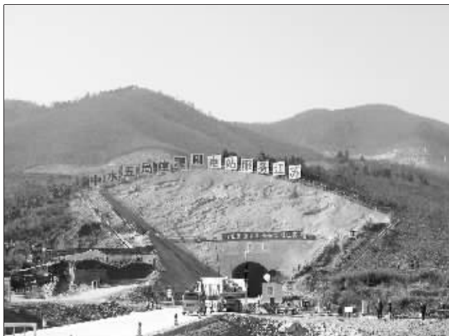
尚在建设中的溧阳抽水蓄能电站
