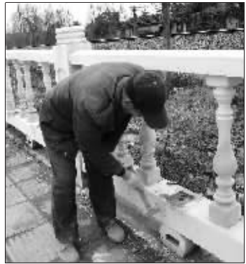
工人正在修复栏杆 是钟寅 摄
