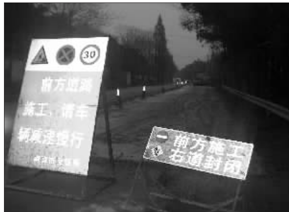
龙西路已有零星的改造施工 快报记者 孙玉春 摄
