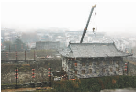
中间一座绞闸楼已经完全拆除,前面这座正在拆除屋顶
