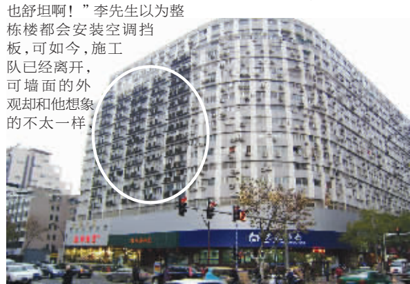
部分外墙已完成美化,看起来整齐统一 快报记者是钟寅摄
