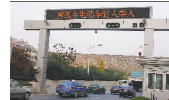
玄武湖隧道入口有电子警示牌,但管不住违禁车辆
