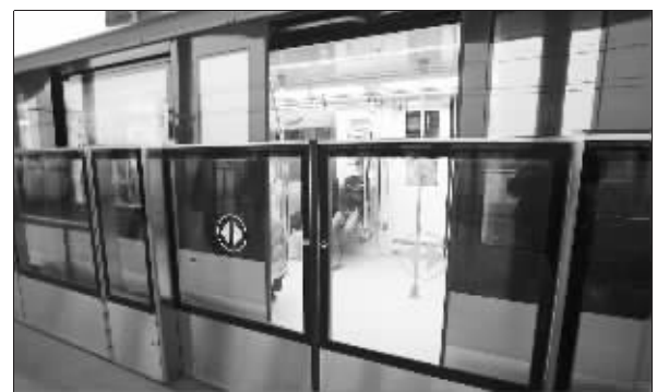
地铁一号线小行站安全门开始启用 快报记者 顾炜 摄
