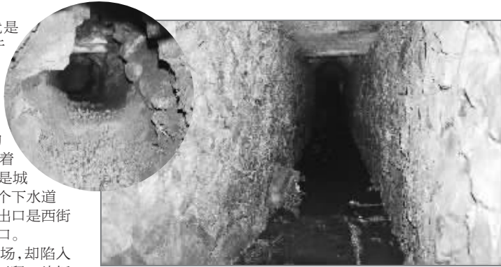
地道入口(左上)及地道内部
