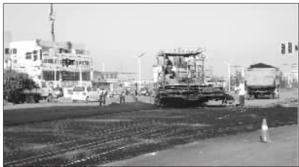
浦珠路改造刚完成,又铲除沥青重新摊铺
