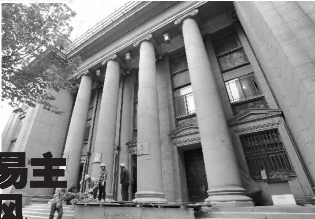
正在维修中的中山东路1号 快报记者 施向辉 摄
