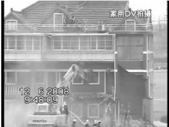
潘蓉放弃了阻挠强制拆迁的行为,房屋最终被推平了
