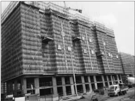
“东方莫斯科”小区建筑工地(资料图片)
