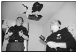
右图为工作人员检查宿舍被爆炸损毁的情况。
