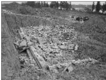
楼房基础被强拆后留下的废墟
