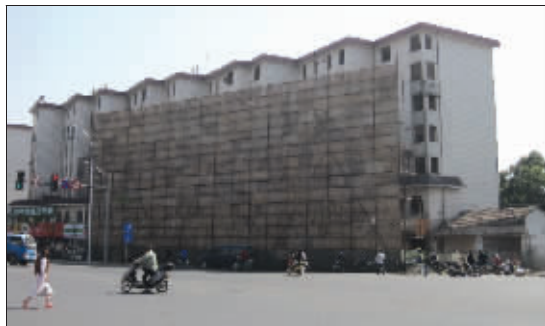
大楼的一半要被拆除,“幸存”建筑里的居民心中不安
