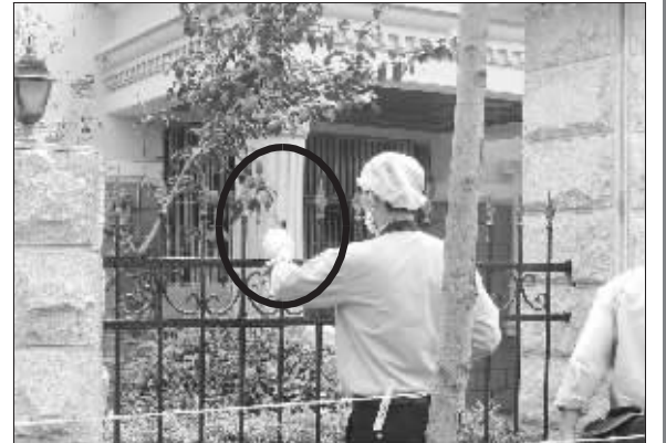
办案人员正在缺失铁尖的栅栏上取证
