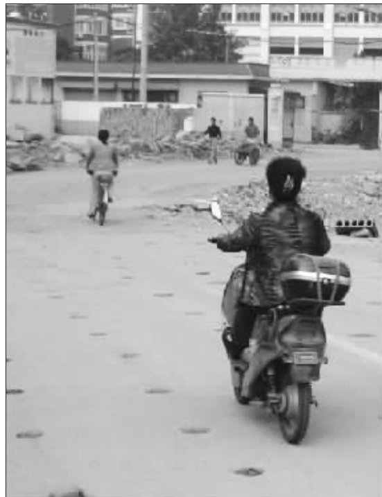
小区前面的水泥路上密密麻麻地打了很多洞
