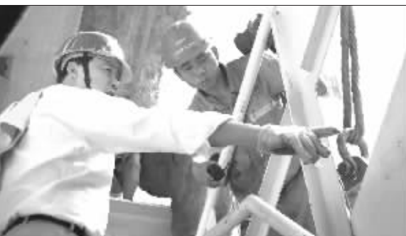
工人正在施工 李兆聪 摄
