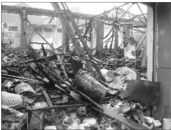
焚烧后的现场一片狼藉
