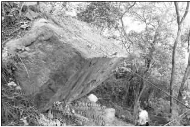
爆破前,排险人员对危岩进行加固 包含摄
