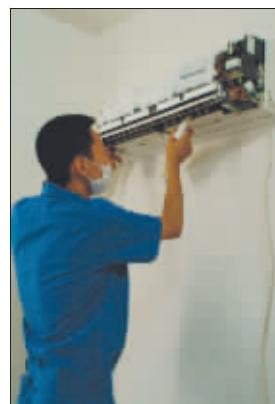
网，由于过滤网是塑料框与涤纶丝压制而成的，在自来水龙头下冲洗即可，不可用40℃以上热水泡洗，以防收缩变形；清洗后将过滤网上的水晾干装好就行。冷凝
